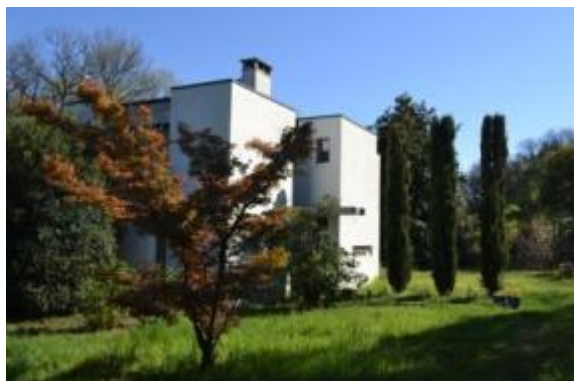
Vista frontale (verso sud)
